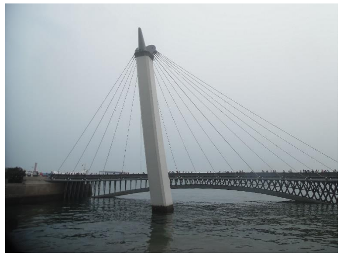
圖二：五四廣場的斜拉行人橋
